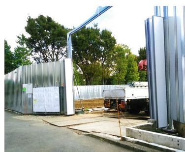
解体中の様子
